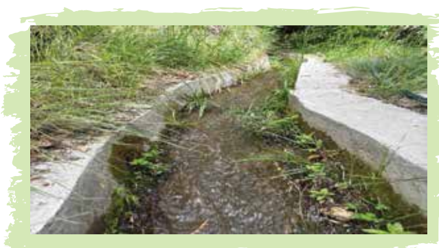
Irrigation Channel (Kuhl) in Powari GP
